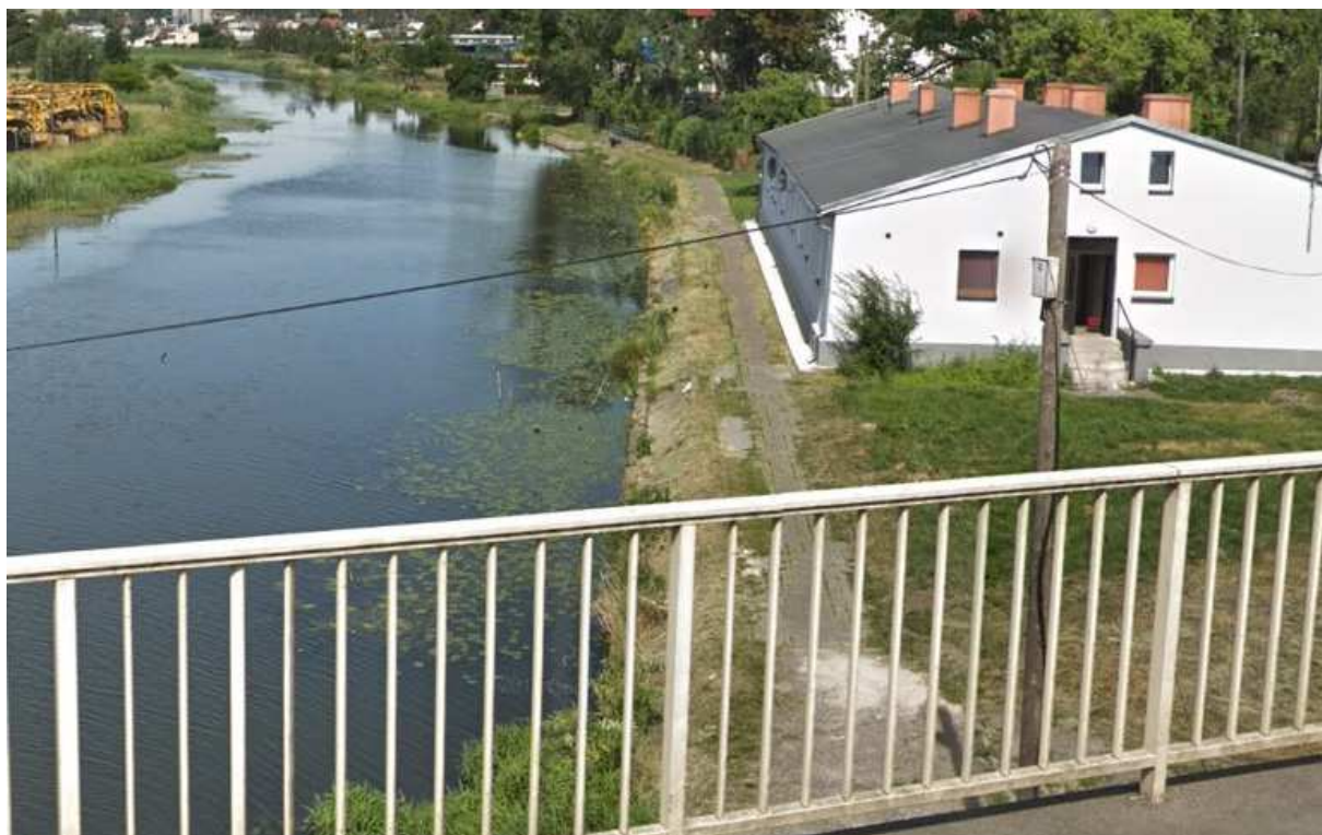
Widok z mostu ul. Poznańska na teren objęty opracowaniem
