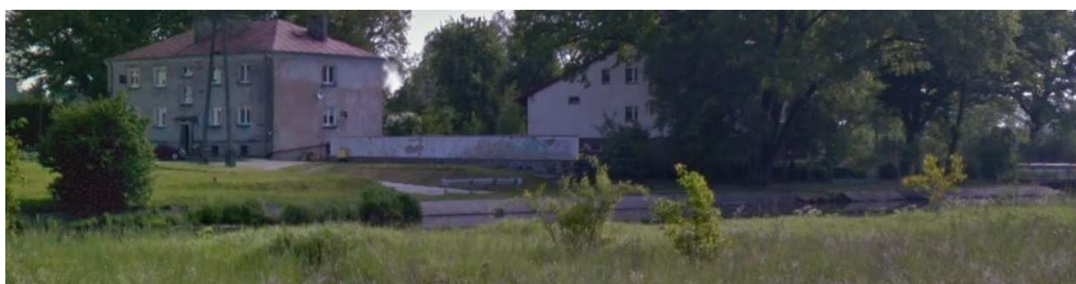
Widok z drugiego brzegu w kierunku terenu objętego opracowaniem
