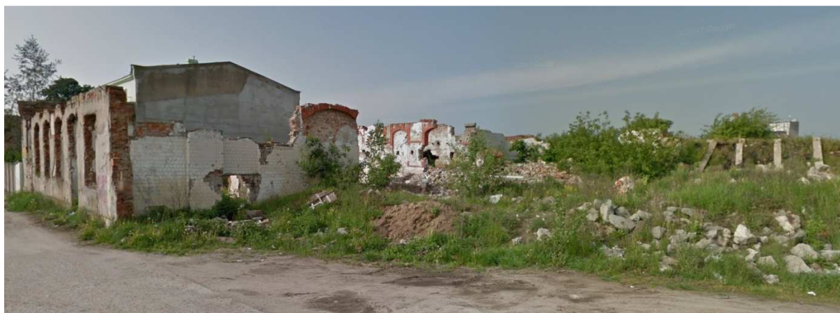
Opuszczone budynki (obszar 2) widok z drogi dojazdowej
