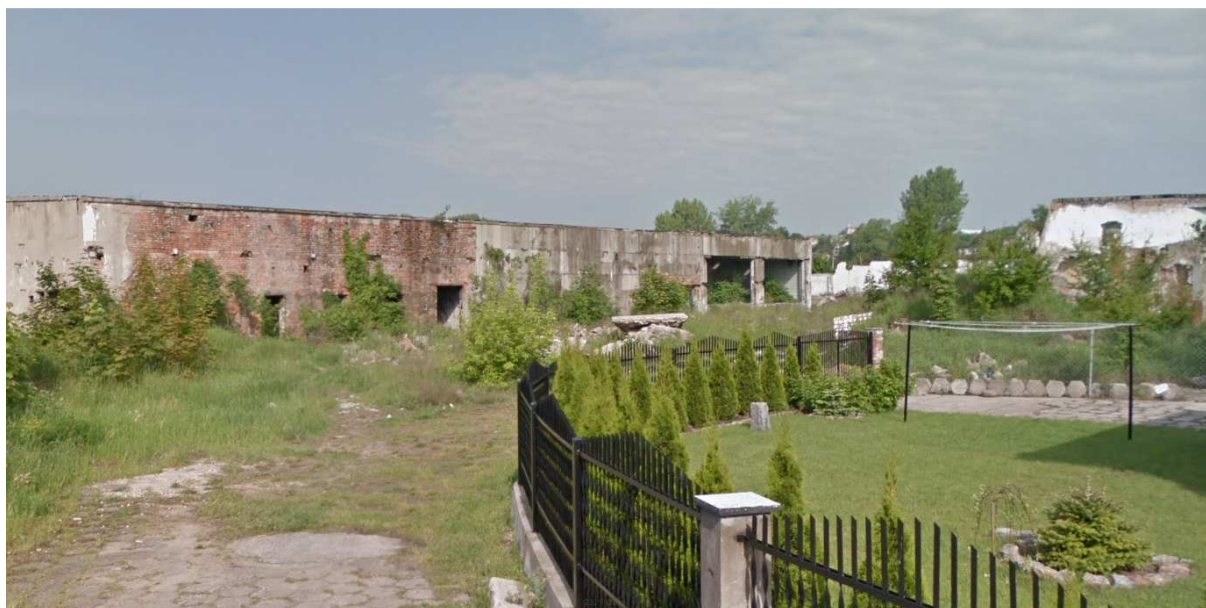
Opuszczone budynki (obszar 2) w sąsiedztwie istniejącej zabudowy
