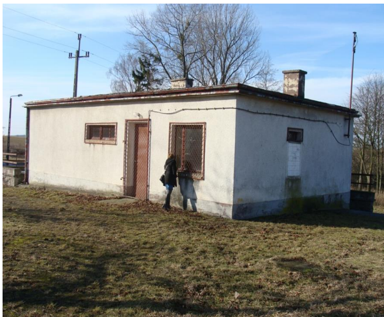
Fot. 7. Budynek w Kazinie
