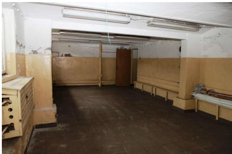
fot. 14. Obiekt w Paterku
