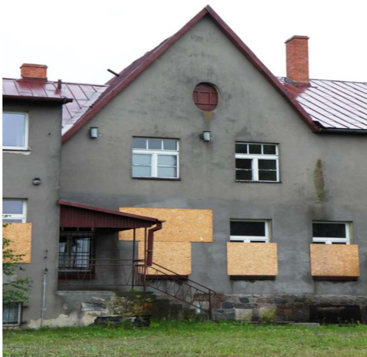
fot. 13. Obiekt w Paterku
