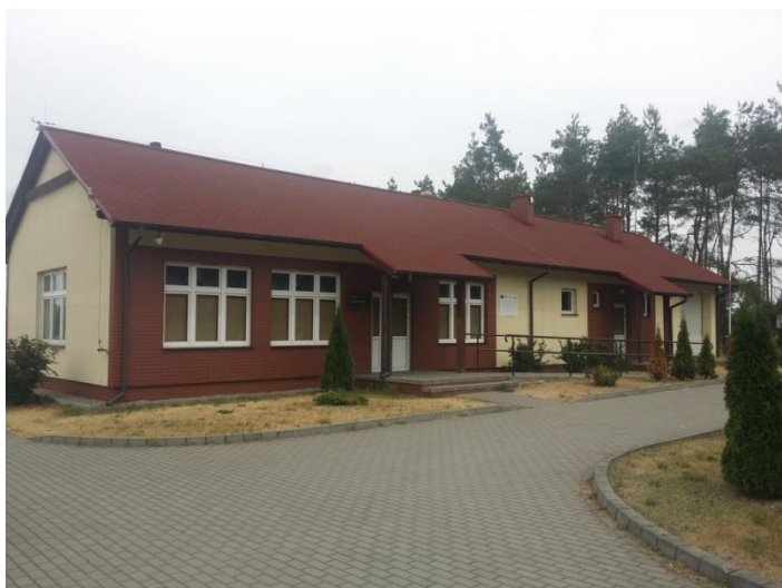
Fot.19. świetlica w Polichnie
