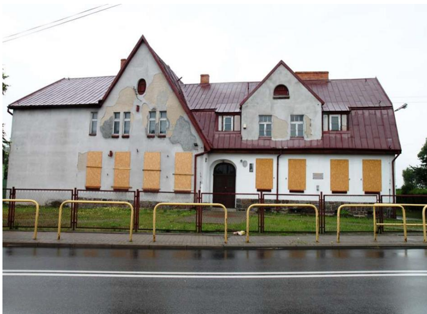
Fot.12. Obiekt w Paterku
