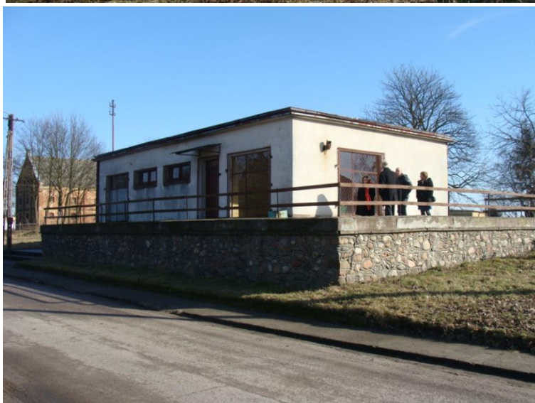
Fot. 8. Budynek w Kazinie
