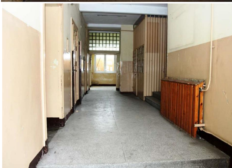
fot. 15. Obiekt w Paterku
