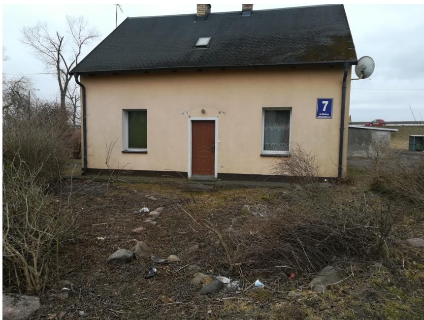
Fot.1. Budynek, ul. Wodna
