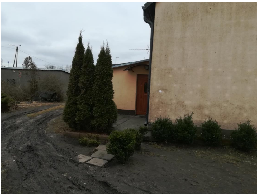
Fot.3. Budynek, ul. Wodna 7
