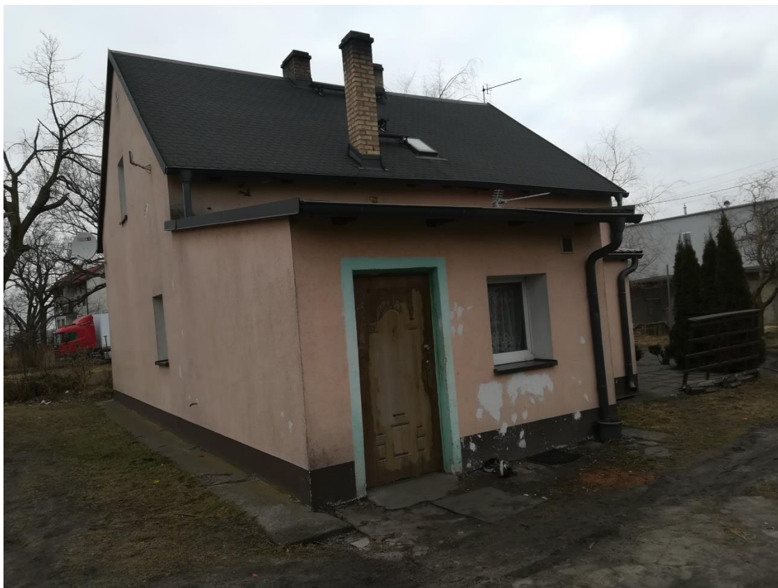
Fot.2. Budynek, ul. Wodna 7
