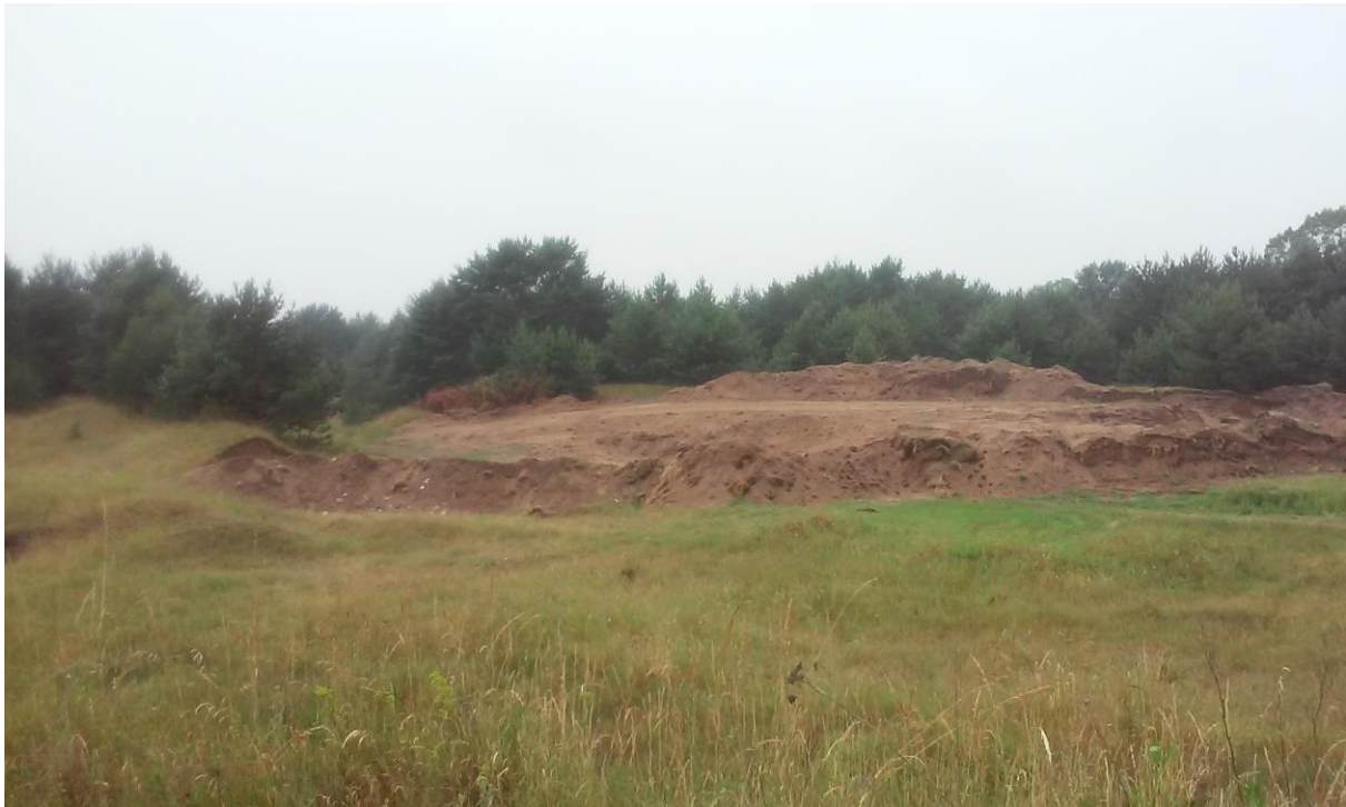
Fot. 5. Efekty pierwszych prac eksploatacyjnych na terenie złoża Rozwarzyn III
